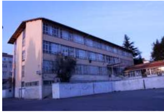
Eski Okul binası -2
