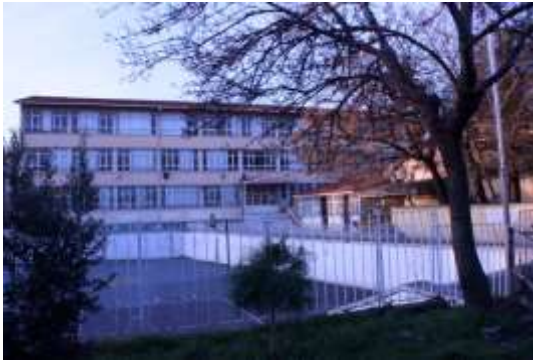
Eski okul binası-1
